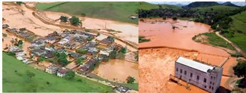
Acidente no rio Muriáe (Foto: Globo,2007)
