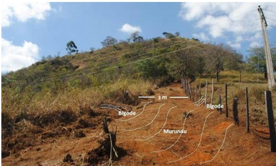
Figura 12 - Indicação de estruturas de controle da erosão e condução de saída d'água em aceiro
