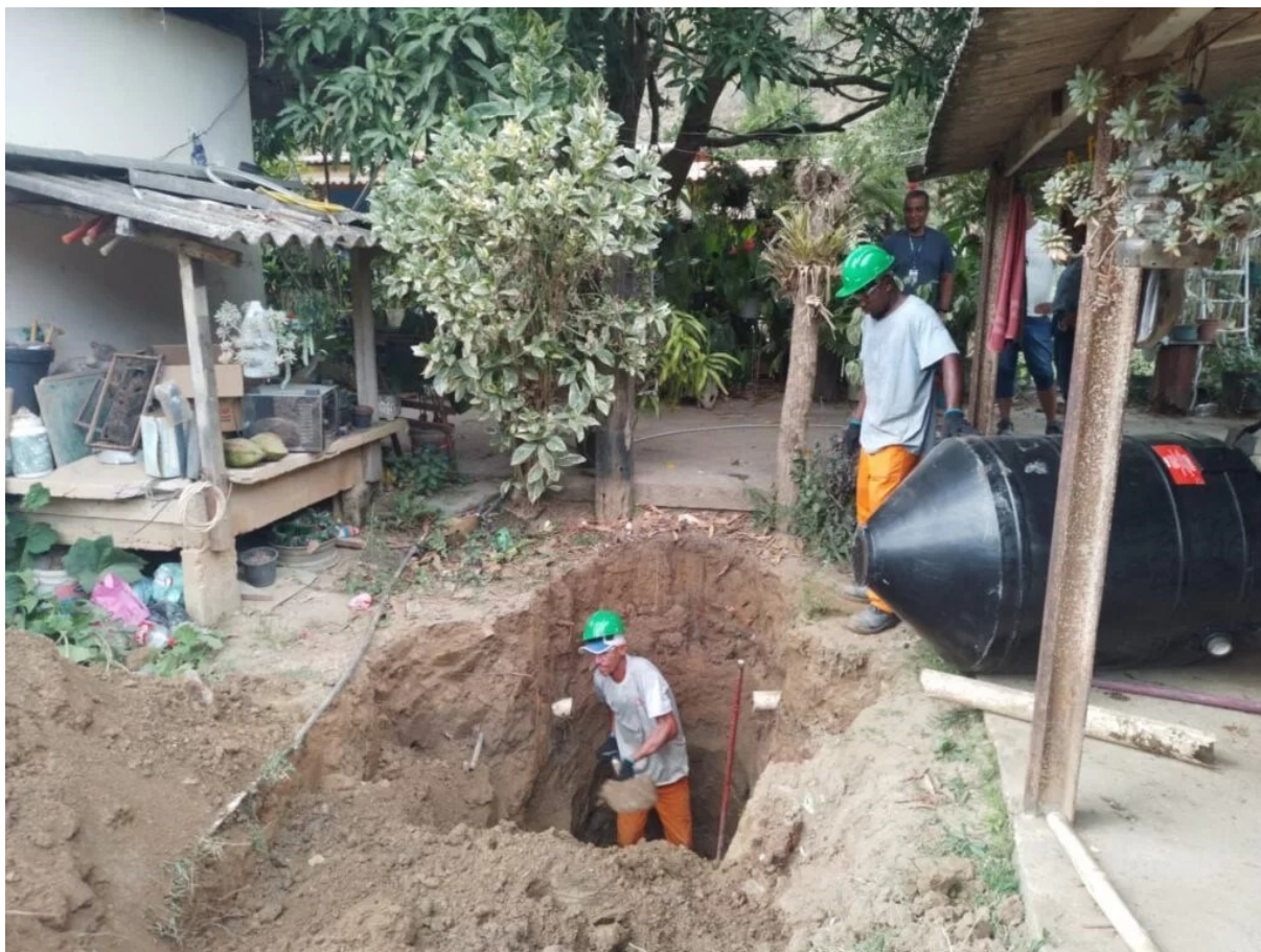
Foto 16 - Implementação de solução de esgotamento sanitário no município de Miguel Pereira/RJ, pelo projeto Sanear Guandu.
