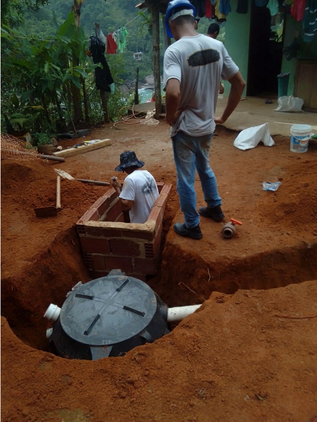
Foto 9 - Instalação dos Biodigestores na localidade de Ponta Negra em Paraty/RJ. Projeto contratado com recursos do FUNDRHI.
