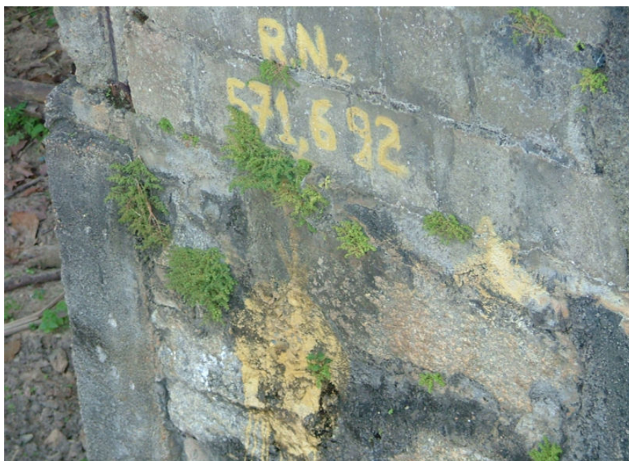
Fig. 19 – RN na Ponte da Avenida Dr. Adhemar de Barros
