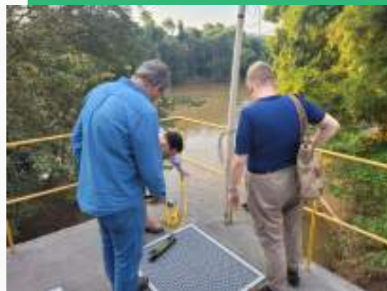
Estação de Tratamento de Água Principal da Águas da Condessa, em Paraíba do Sul-RJ
