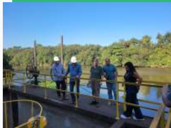
Estação de Tratamento de Água (ETA) do Belmonte, em Volta Redonda
